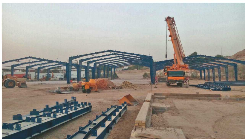
▲ پروژه طراحی و ساخت ساختمان آستان قدس علوی به مساحت ۱۸ هزار متر مربع در نجف اشرف (کشور عراق)
